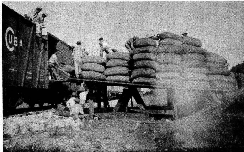
Cargamento de mineral de asfalto en el muelle de la mina Esperanza. coto de Bellamota.
